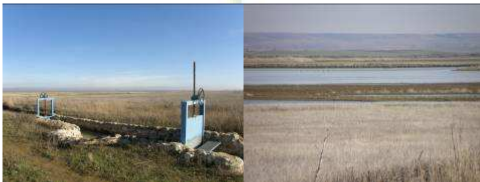
Obras de restauración de la pradera de “El Hoyo”
